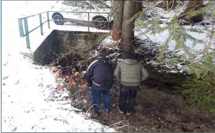
Brückeninspektion mit der Güterwegerhaltung des Landes
