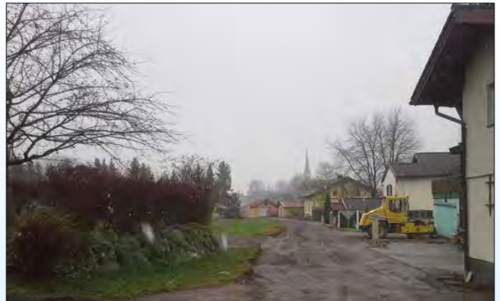
Baubeginn Cäciliagasse im Herbst 2017, Erdbauarbeiten abgeschlossen
