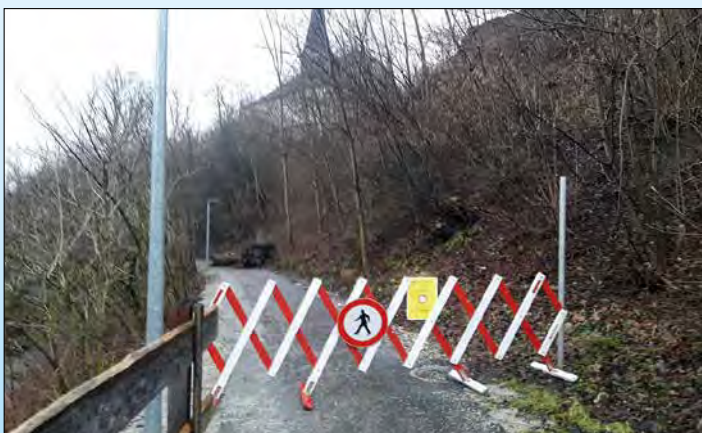
Wegsperre auf Grund Hangrutsch Kirchleiten - Aufräumarbeiten nach Wetterbesserung geplant.
