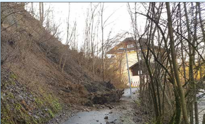
Räumung und Sanierung ist bereits im Plan
