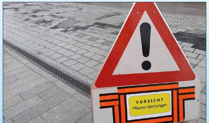
Pflaster beim Stadtplatz - Sanierungsarbeiten bereits eingepplant
