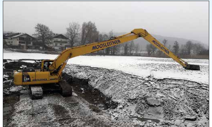
Spezialbagger im Sighartsteiner Weiher
