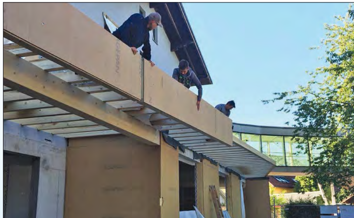
Die Volksschule Neumarkt wird für die Nachmittagsbetreuung erweitert
