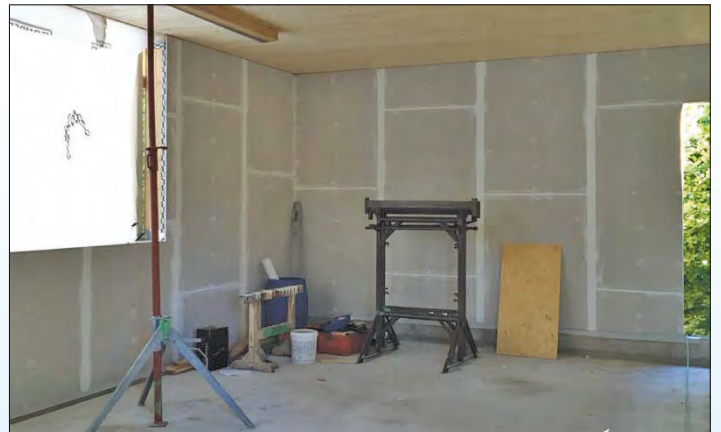
Innenausbau in der Volksschule Neumarkt
