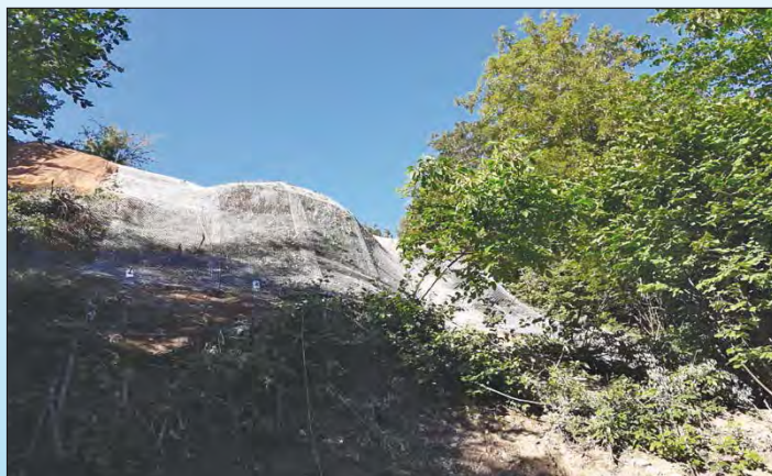
Sanierung Schanzwall nach Jännerhangrutsch mit aufwändiger Vernetzung und Vernagelung abgeschlossen
