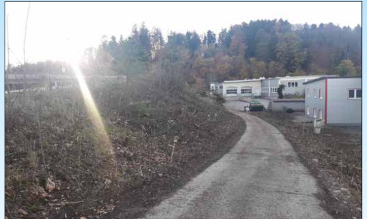
Erhöhung der Verkehrssicherheit durch Baumrodung in der Pfongauerstraße
