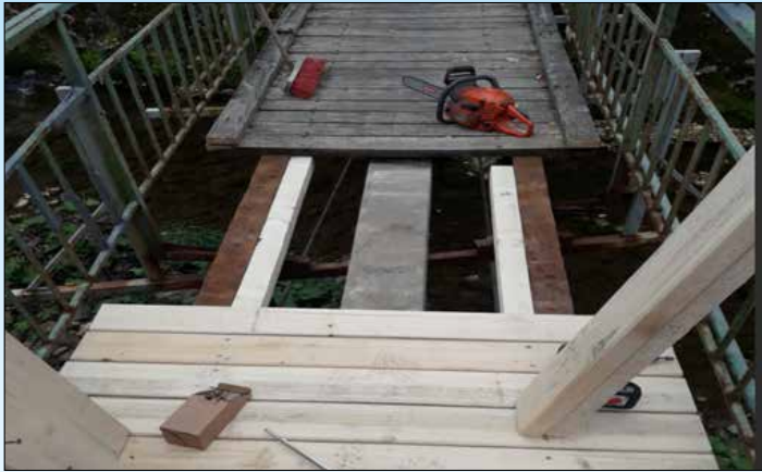
Austausch des alten Holzbelages beim Steg Wallerbach
