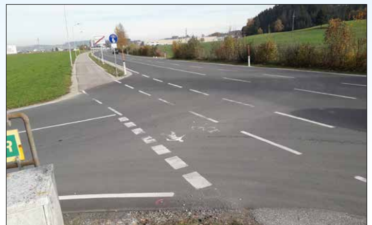
Geh- und Radweg nach Steindorf an der L-206 fertig gestellt
