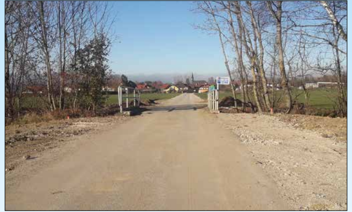
Verbreiterung der Straße von Pfungau zu Firma Trapp
