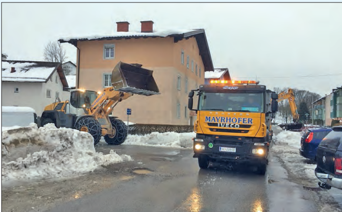
Auch Firmen wurden für die Schneeräumung beauftragt
