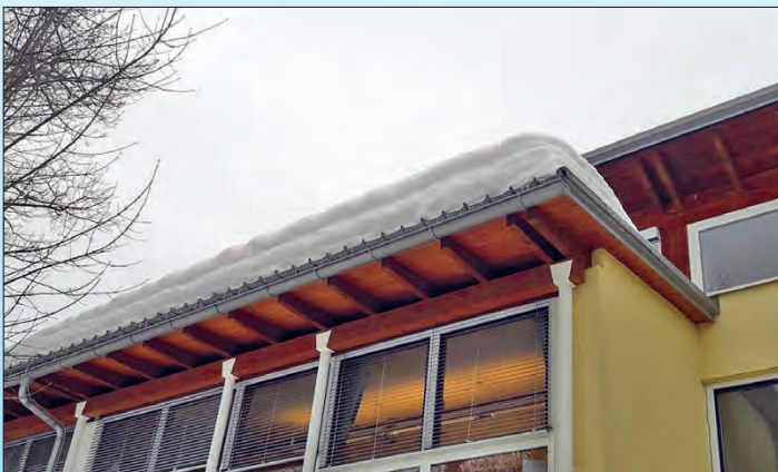
Schneewechten wurden durch externe Werknehmer entfernt - danke an die Zimmerei Frauenschuh u. an die Spenglerei Leodolter
