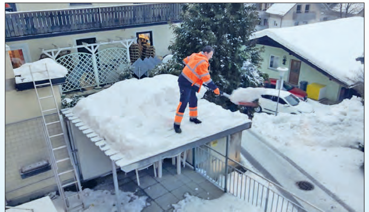
Abschneefeln diverser Flachdächer öffentlicher Gebäude durch unsere fleißigen Bauhofmitarbeiter
