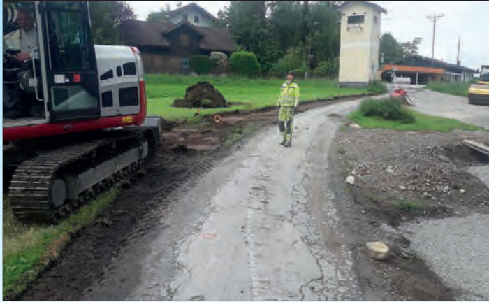
Seeweg (auf Höhe Liebrecht) im Rohbau
