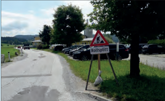
Achtung Rollsplitt – die Deckensanierer waren unterwegs
