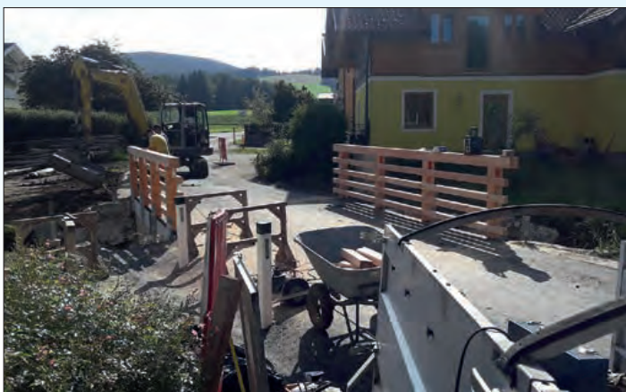
Brücke über den Pfgongauerbach fertig – danke an die Nachbarn und den Güterwegeerhaltungsverband (GWEV)
