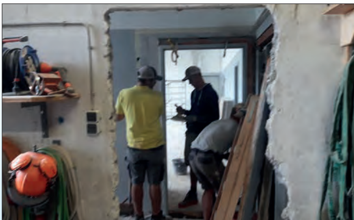
Umbauarbeiten für Kindergarten-Provisorium im Untergeschoß (ehemaliger Bauhof) kurz vor Abschluß
