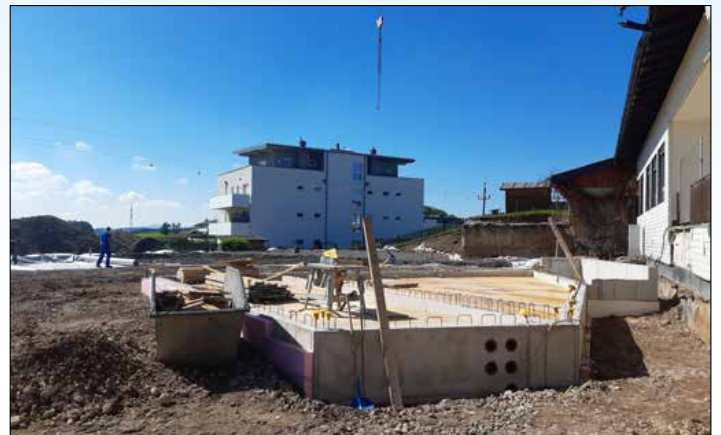
Keller des neuen Kindergartens im Schulzentrum ist bereits fertig
