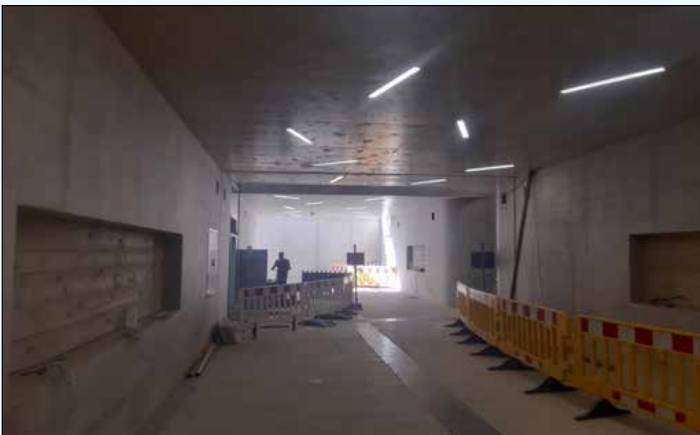
Neue Unterführung beim Bahnhof Neumarkt
