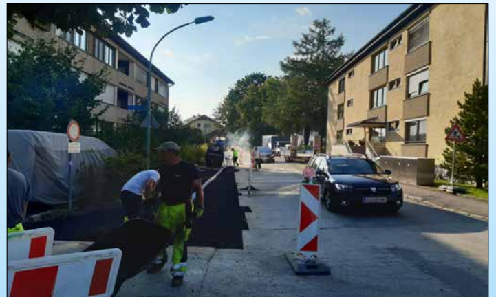
Oberflächen-Entwässerung und Gehsteigsanierung Siedlungsstraße erster Baubchnitt fertiggestellt
