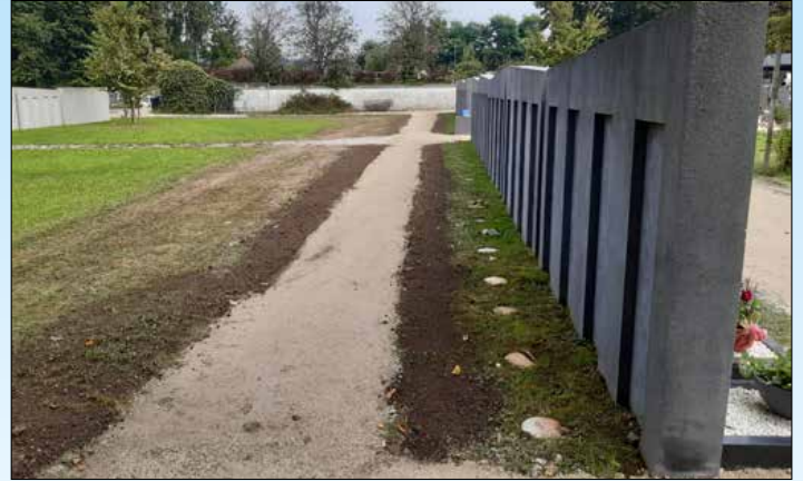
Neu angelegte Wege beim Friedhof
