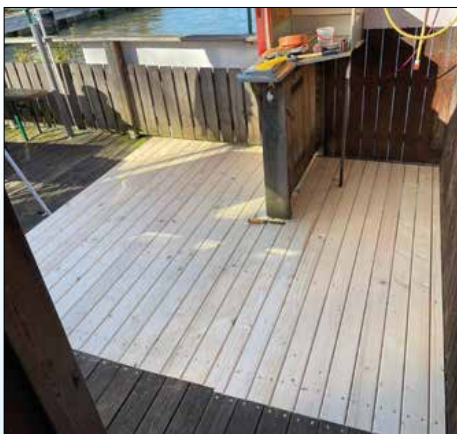
Holzbelag bei Bootsvermietung erneuert
