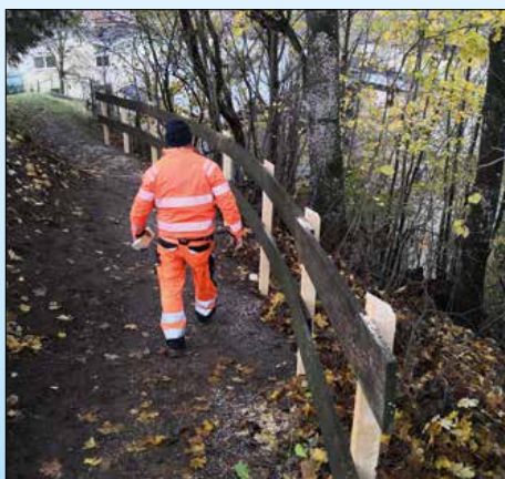
Zaun Friedhof Richtung Wallbachstraße repariert
