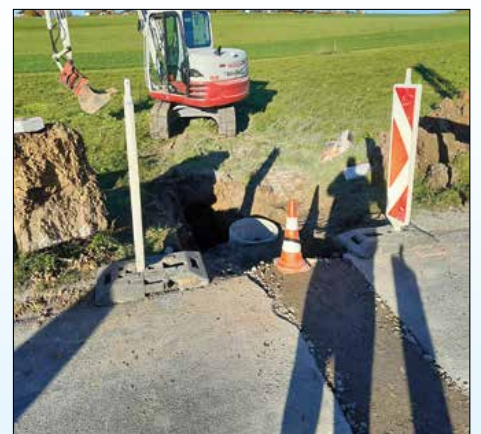
Rohrdurchlass Matzing mit dem GWEV erneuert
